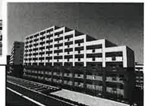
柱や梁、床・壁が鉄筋とコンクリートで構成された鉄筋コンクリート造
